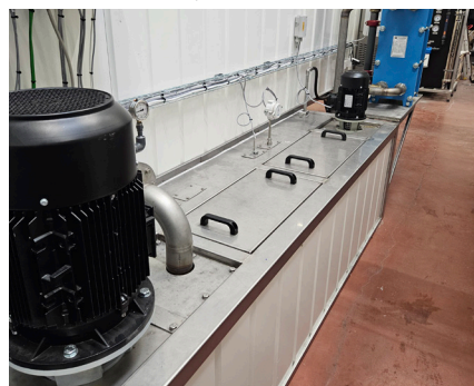
I augusti installerades en stor förbehandlingsanläggning hos ett lokalt företag i Skillingaryd.
