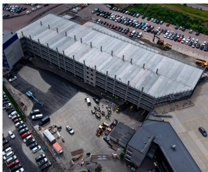
Gekås har varit kund hos LGL Construction i 40 år. Det nya P-huset ger plats för ännu fler besökare.
